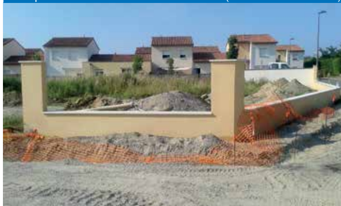
Vue depuis l'amorce de la rue au bout du lotissement (avec vue clôture du lot n°1)
