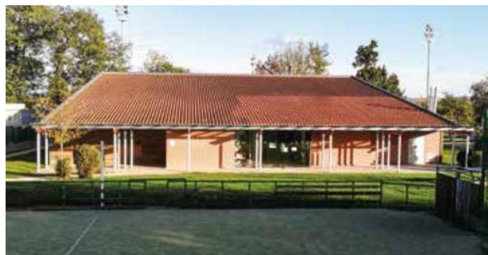
DRP4 COUPE PROJET - SALLE POLYVALENTE - LHERM. Renforcement isolation sous couverture toiture. Remplacement Tiges de Vitrage. Coffre vitre isolé double vitrage.
