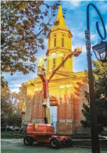
Les travaux ont consisté au remaniement complet de toutes les toitures : des chapelles, de la nef et du clocher, avec nettoyage par brossage, pulvérisation d'anti-mousse, reprise des habillages en zinc, reprise des 2/3 de la charpente de la toiture des chapelles côté Sud, et mise en œuvre de descentes pour les toitures basses qui n'en comportaient pas.
