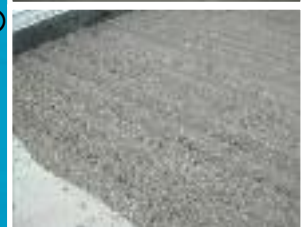
➡ Arrivée des premières boues séchées.
