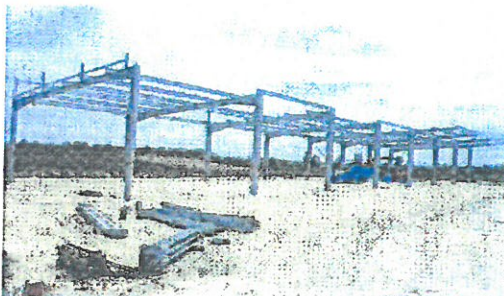
Hangar en construction
