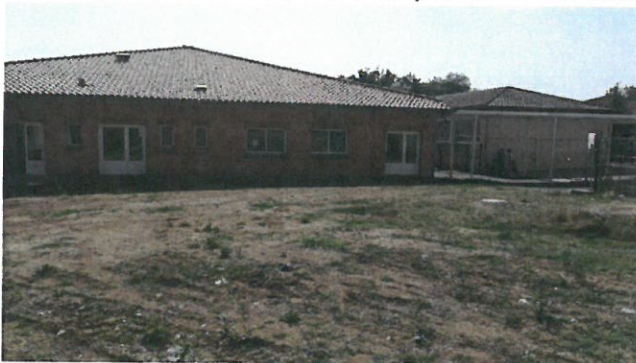
Arrière du bâtiment
