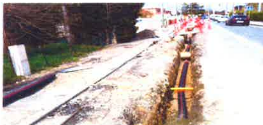
Chantier de renforcement des réseaux électriques
