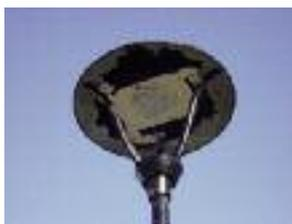
puisque la totalité des 4 têtes de candélabres (protecteurs en verre et supports des blocs optiques à LED) ont été systématiquement détruits.
