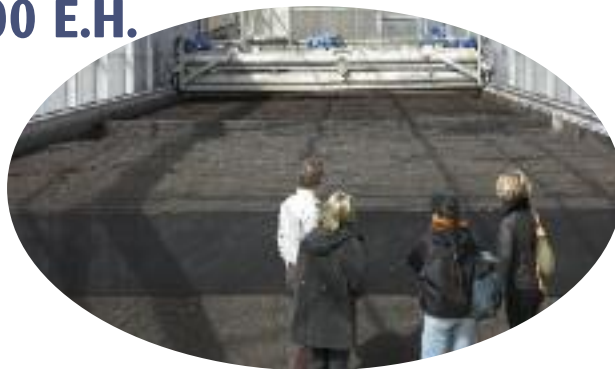
🕒 Visite au cœur de la STEP, dans le sécheur solaire, avec la manœuvre, le robot d'étalement des boues.
