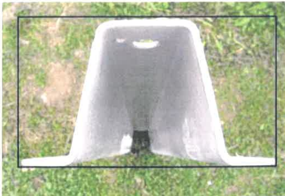
Figure 9 : Pieu enfoncé dans le sol en forme de « oméga » pour une meilleure résistance
