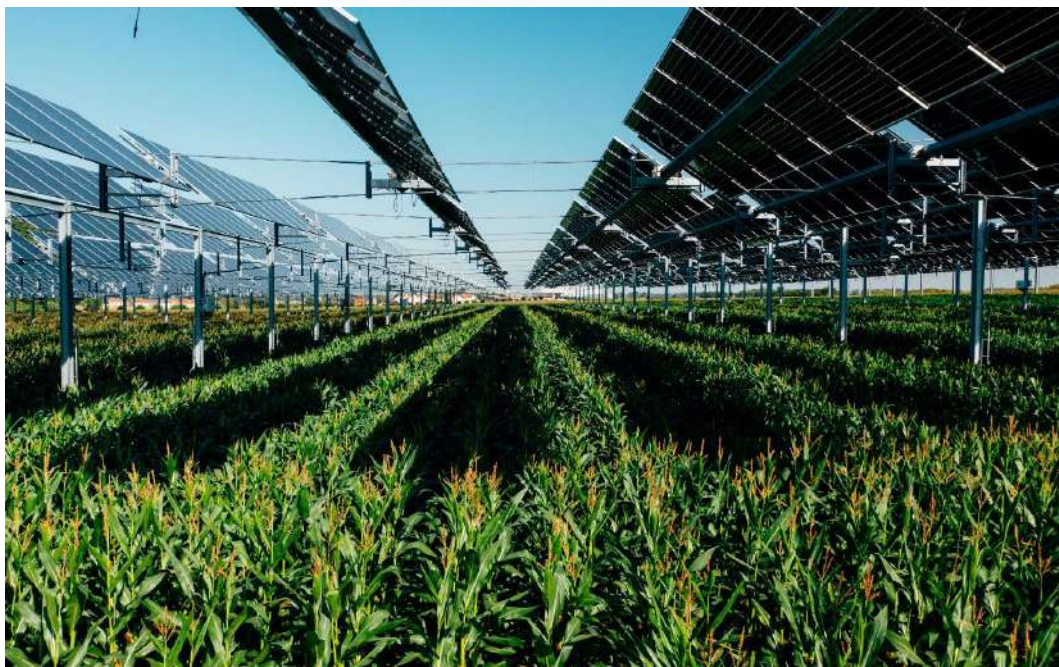
Illustration photographique des ombrières à Brouchy (canopée et irrigation sur grandes cultures)
