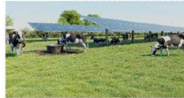
L'ombrière d'élevage Un système d'ombrière permettant l'atténuation des effets du changement climatique sur la prairie et sur l'élevage grâce à un ombrage tournant.
