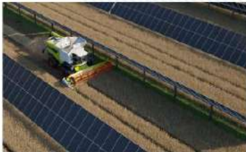
L'ombrière de culture Une ombrière pour les cultures basses et moyennes, qui répond aux besoins agro-climatiques des cultures et les protège des aléas climatiques.
