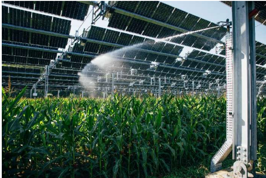
Illustration photographique des ombrières à Brouchy (canopée et irrigation sur grandes cultures)
